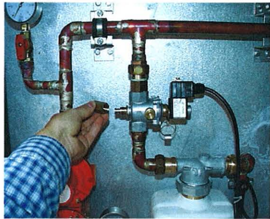
2. Skru av hetten under magnetventilen
