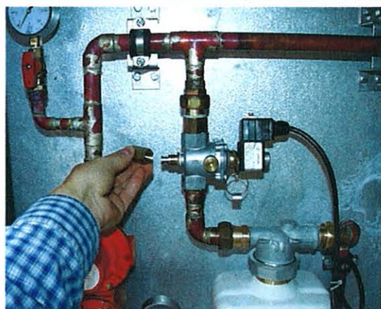
2. Skru av hetten under magnetventilen
