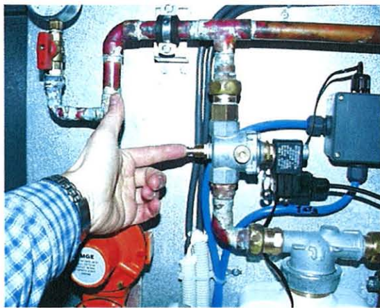
3. Trykk inn magnetbryteren
